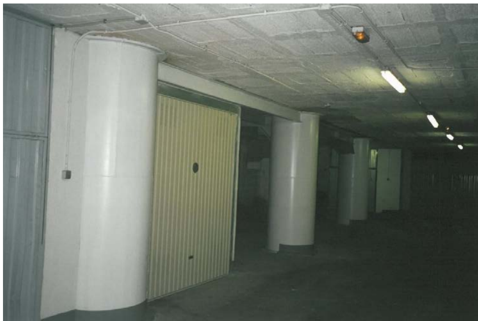
Figura 5: Refuerzo definitivo de los pilares más afectados
