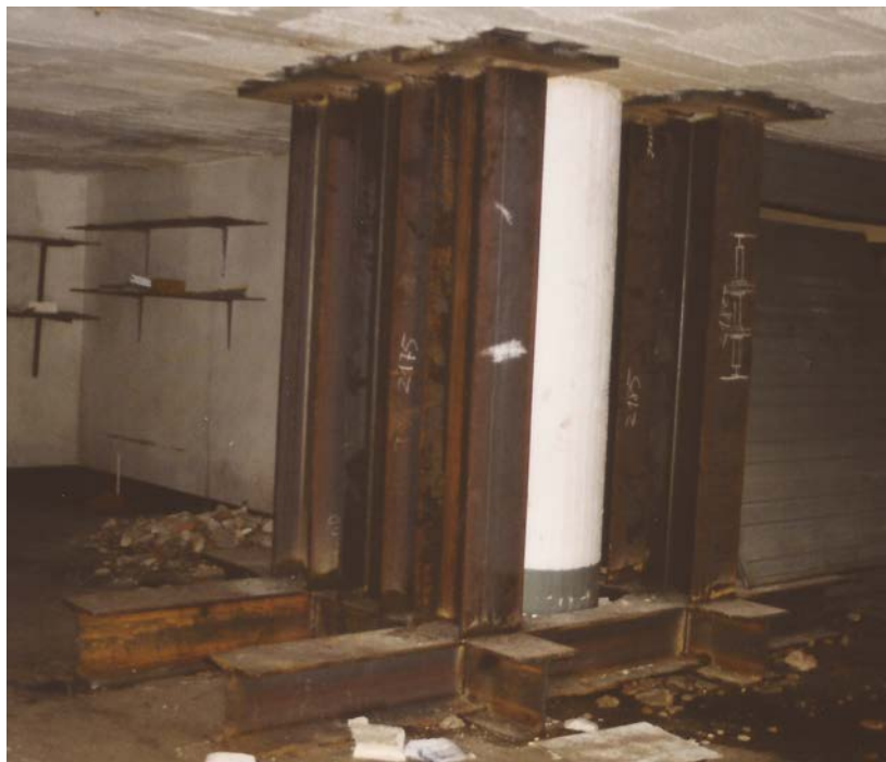
Figura 3: Pórticos de refuerzo provisional a nivel de: a) planta baja, b) sótano -1 y c) sótano -2
